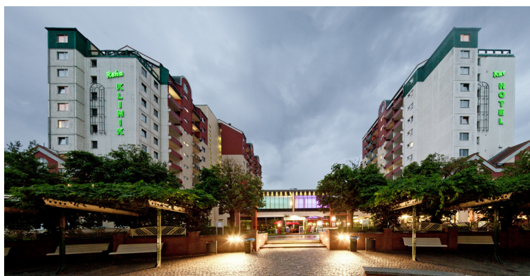
Zwei Gebäude – ein Problem: Kurhotel (rechts) und Kurklinik liegen sich unmittelbar gegenüber und sind über einen Querriegel verbunden. In diesem Verbindungsteil sind die Schwimmhallen untergebracht. Beide Schwimmbadanlagen standen jetzt zur Sanierung an.
