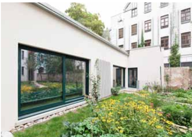
Eine alte Remise mitten im Zentrum von Berlin wurde zu einer Schwimmhalle umgebaut. Die dichte Wohnbebauung ringsum störte den Bauherrn nicht.
